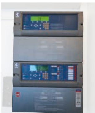
Système de sécurité incendie de catégorie A
