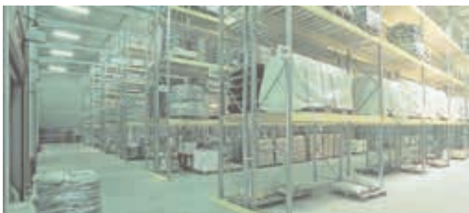
Renouvellement de votre installation.
