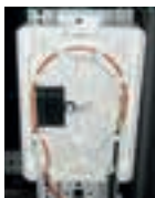
Boîtier micro-épissure pour assurer la jonction entre la terminaison fibre optique et la fibre DTS
