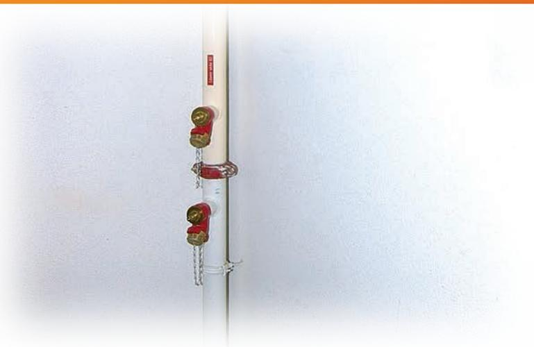
**Les colonnes d'incendie sont des tuyauteries fixes et rigides destinées à véhiculer l'eau dans les différents niveaux d'un bâtiment et à faciliter l'intervention des Sapeurs-pompiers.**
