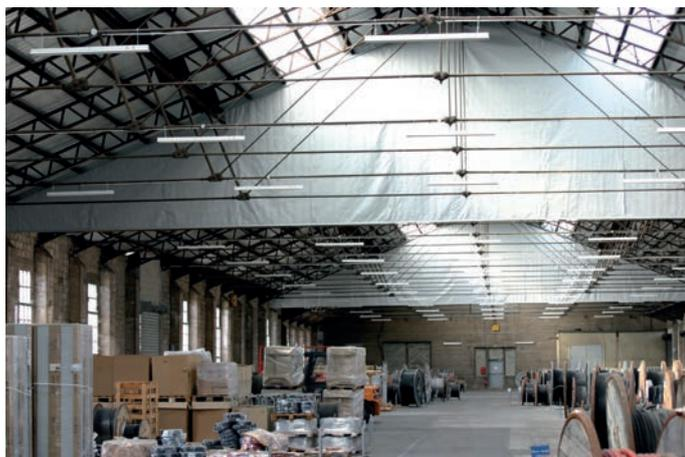
La réglementation impose, sur certains volumes à désenfumer, de mettre en place des écrans de cantonnement pour canaliser les fumées chaudes en partie haute, et faciliter ainsi leur extraction.
