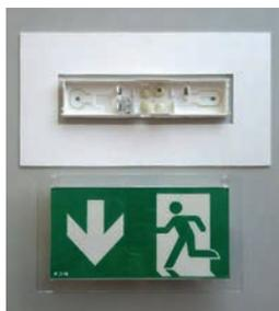
Lors du remplacement de BAES, les dimensions des blocs peuvent être différentes. Pour pouvoir recouvrir proprement l'empreinte du bloc déposé, il est possible d'intercaler une plaque PVC prédécoupée :
